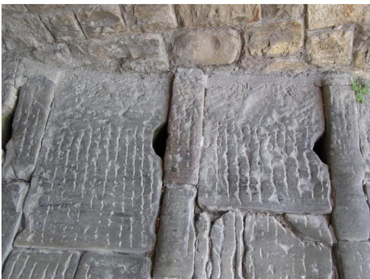
Ponegdje se mogu naći direktni priključci kućne kanalizacijske vertikale na kanal. Sve glavne vertikale povjesne kanalizacije su izrađene od kamenih blokova, pa tako i račve.
